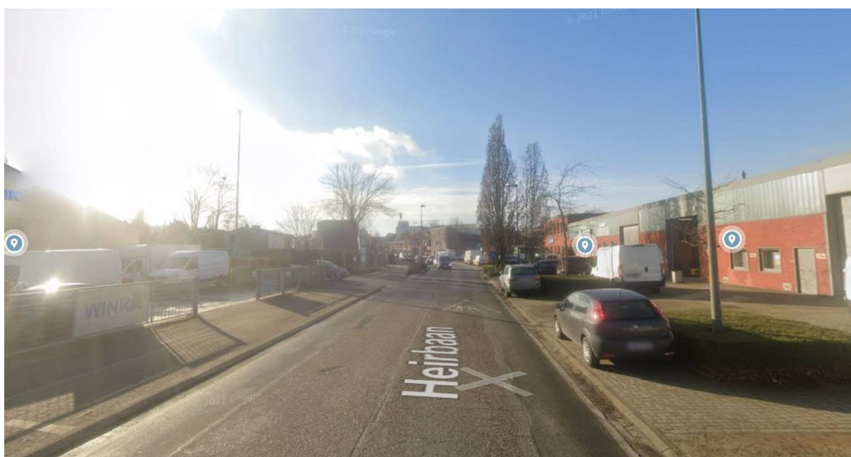
Figuur 24. Voorbeeld van een KMO-zone (Heirbaan). Bron: Google Maps.
