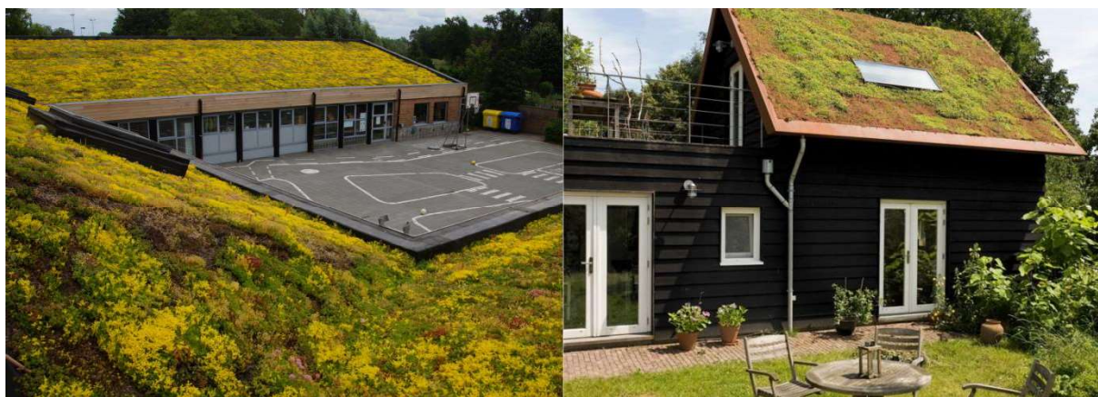
Figuur 31. Voorbeelden van groendaken. Links wordt een groendak toegepast op een groot, weinig hellend dak van een school. Rechts is het toegepast op het dak van een privé woning. Bron: Blauwgroen Vlaanderen.
