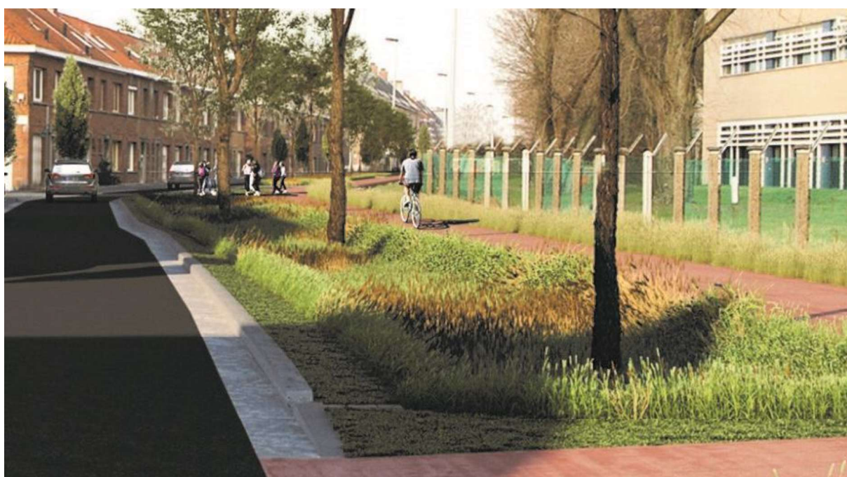
Figuur 27. Voorbeeld van een wadi uit het project Cluster Steenakker Gent. Bron: Blauwgroen Vlaanderen.
