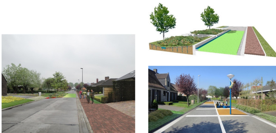
Figuur 14: Sfeerbeelden uit het participatietraject in de wijk Kroonhove in Oostkamp. De vorm van de betonplaten werd gebruikt als structurerend element voor de nieuwe "plaatinvullingen". Bouwheer: Gemeente Oostkamp - Studiebureau NERO architectuur en stedenbouw en landschapsarchitect Denis Dujardin.
