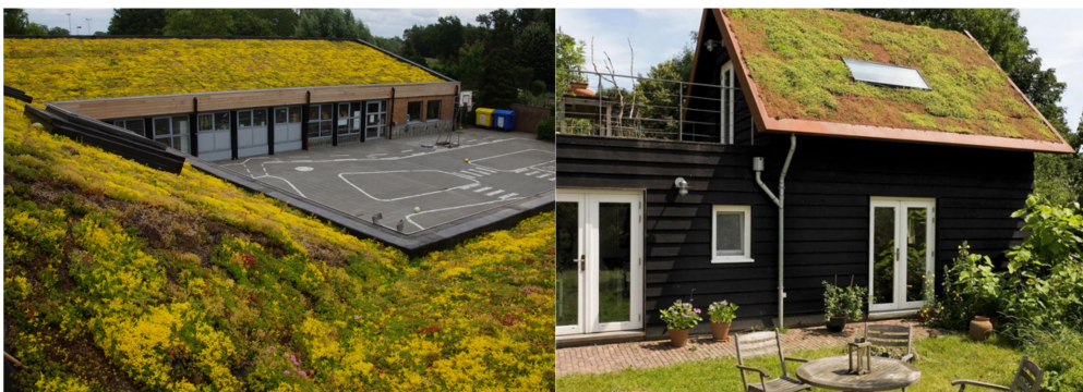
Figuur 32. Voorbeelden van groendaken. Links wordt een groendak toegepast op een groot, weinig hellend dak van een school. Rechts is het toegepast op het dak van een privé woning. Bron: Blauwgroen Vlaanderen.
